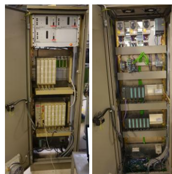
Schaltschrank vorher und nachher
